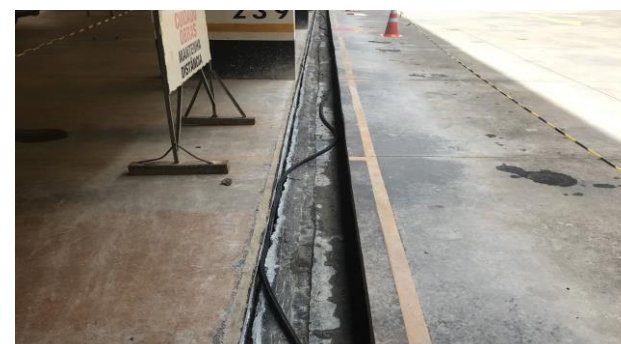
F8 – Colocação de junta Jeene – etapa 2
