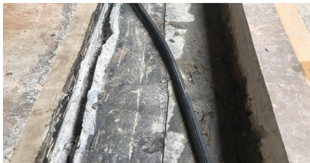
F9 – Colocação de junta Jeene – etapa 2
