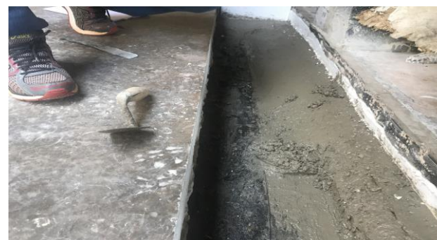
F5 – Arremates da vigota com a laje
