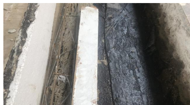
F7 – Vista da vigota de concreto c/armação
