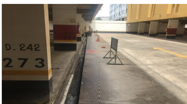
F3 – Execução de vigota de concreto
