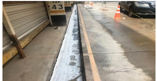
F2 – Impermeabilização e colocação de bidim na canaleta da etapa 2
