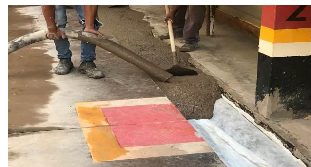
F8 – Concretagem da canaleta da Etapa 1
