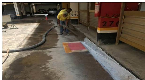
F7 – Concretagem da canaleta da Etapa 1
