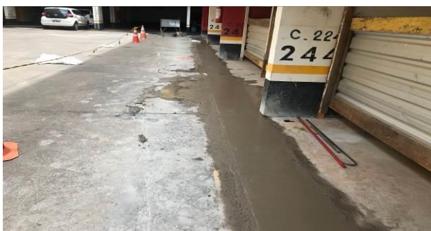
F11 – Regularização do concreto
