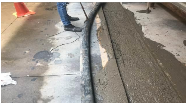
F3 – Concretagem da canaleta da Etapa 2
