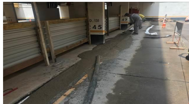
F5 – Concretagem da canaleta da Etapa 2
