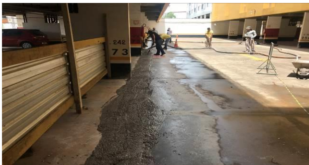
F9 – Concretagem da canaleta da Etapa 1
