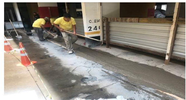
F4 – Concretagem da canaleta da Etapa 2
