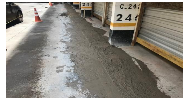
F6 – Concretagem da canaleta da Etapa 2
