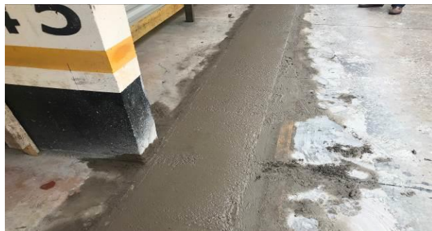
F12 – Regularização do concreto
