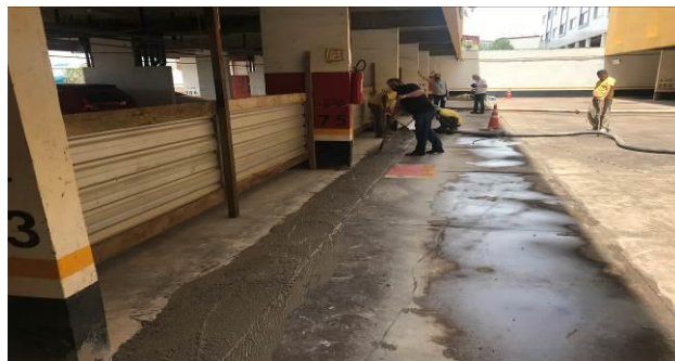
F10 – Concretagem da canaleta da Etapa 1
