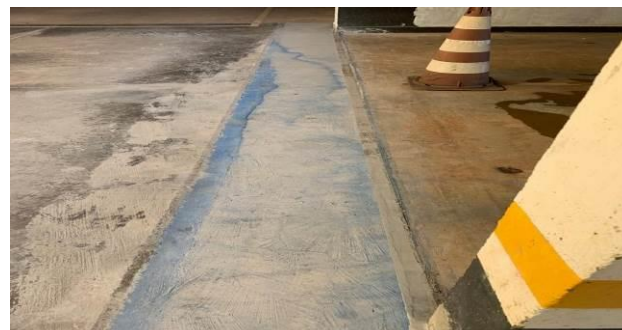
F14 – Teste de estanqueidade juntas 1/2
