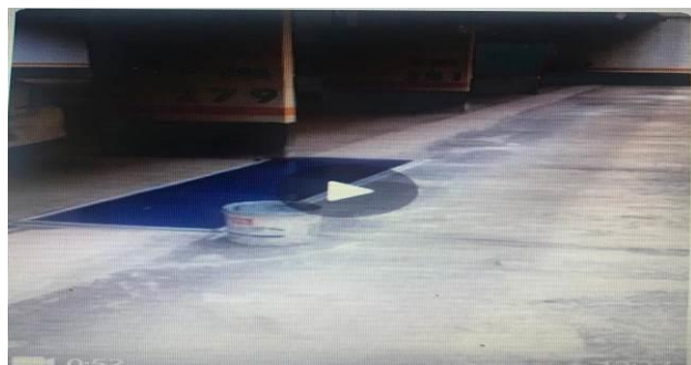
F13 – Teste de estanqueidade juntas 1/2
