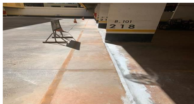
F12 – Nova recuperação junta etapas 1/2
