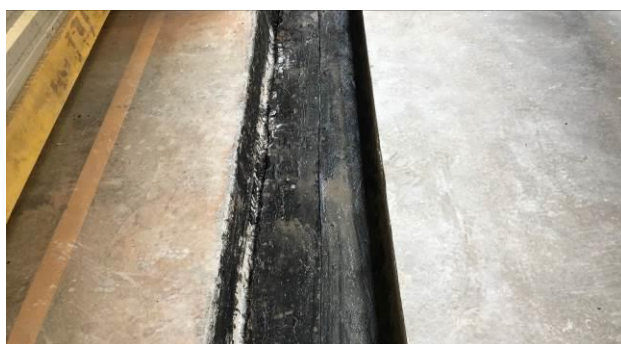
F3 – Abertura canaleta da Etapa 3
