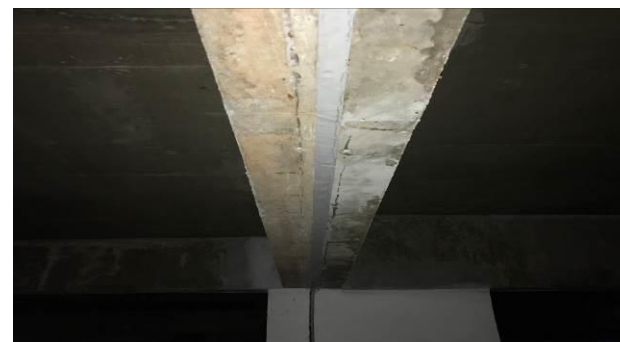
F8 – Calafetação inferior das juntas entre vigas
