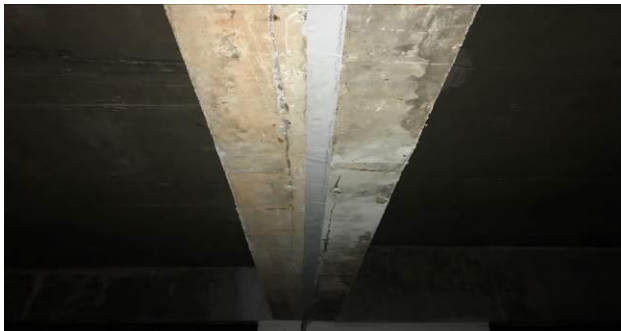
F9 – Calafetação inferior das juntas entre vigas
