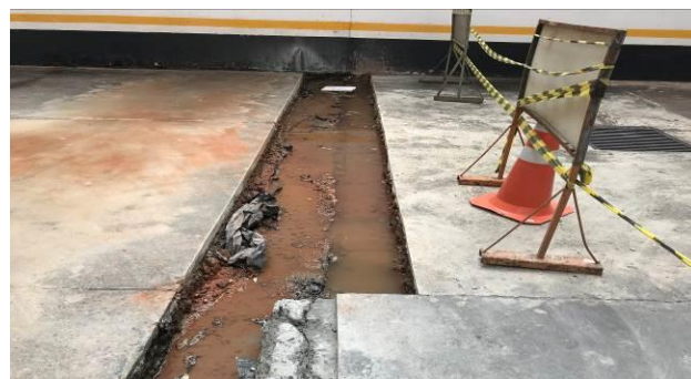
F7 – Abertura de vala na junta da etapa 5 (rampa)
