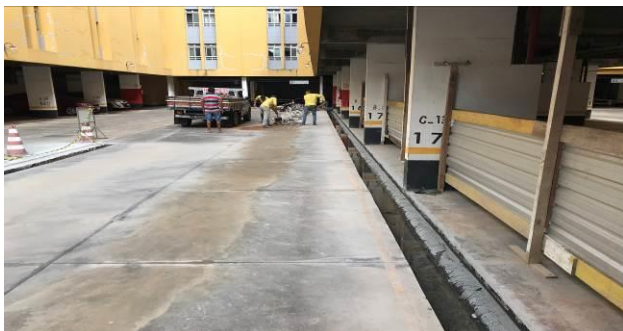
F1 – Tratamento juntas da Etapa 4
