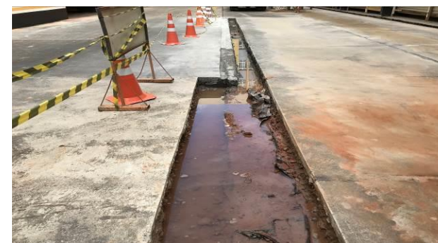
F6 – Abertura de vala na junta da etapa 5 (rampa)
