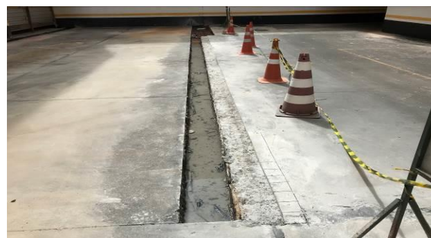
F5 – Abertura de vala na juntas da etapa 5 (rampa)
