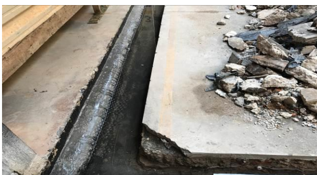
F3 – Tratamento juntas da etapa 4
