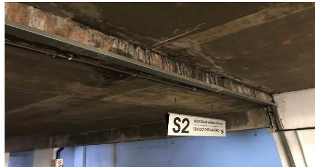
F10 – Aspecto da junta em frente a rampa
