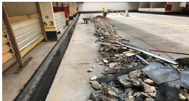
F2 – tratamento juntas da etapa 4
