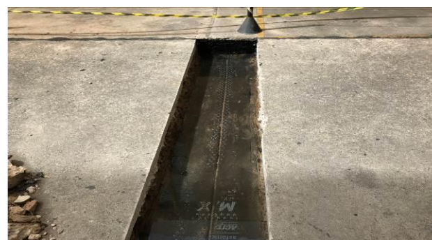
F4 – Tratamento juntas da etapa 5
