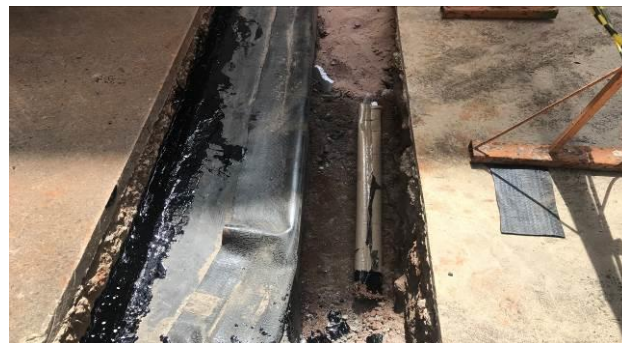
F5 – Impermeabilização junta em frente à rampa de veículos (etapa 5)
