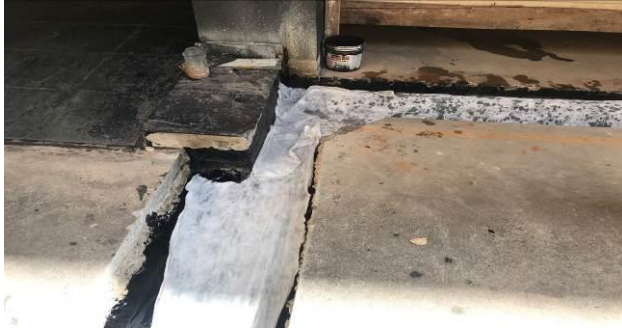
F1 – Preparo canaleta para concretagem
