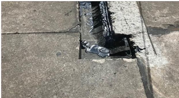
F3 – Canaleta etapa 5 – Preparo para concretagem
