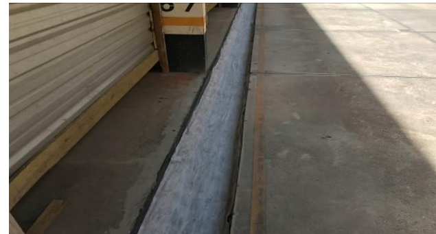
F4 – Impermeabilização da canaleta e da junta da Etapa 4
