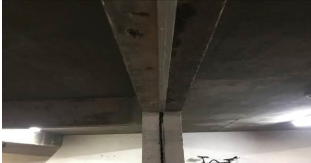
F25 – Tratamento parte inferior da junta (2º subsolo)
