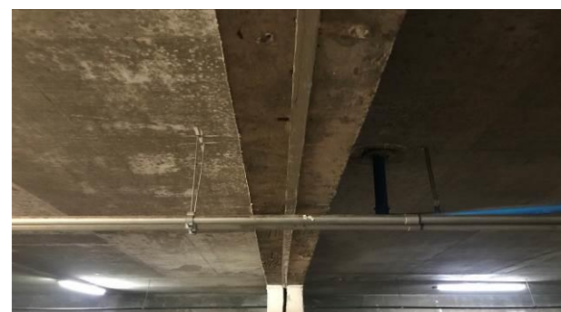
F24 – Tratamento parte inferior da junta (2º subsolo)
