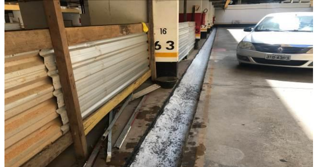
F2 – Canaleta etapa 3 – Preparo para concretagem
