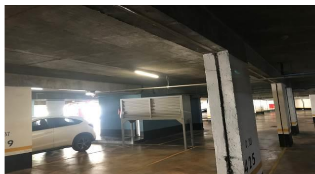
F23 – Tratamento parte inferior da junta (2º subsolo)
