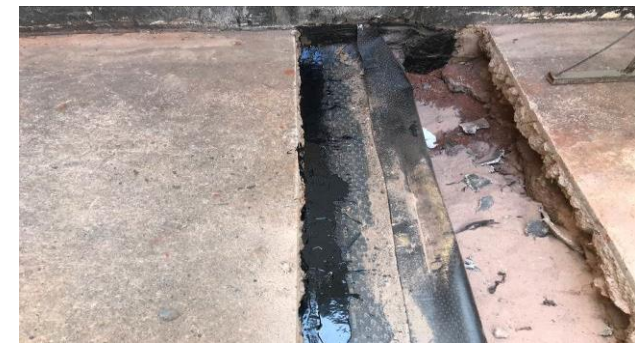
F6 – Impermeabilização junta em frente à rampa da garagem
