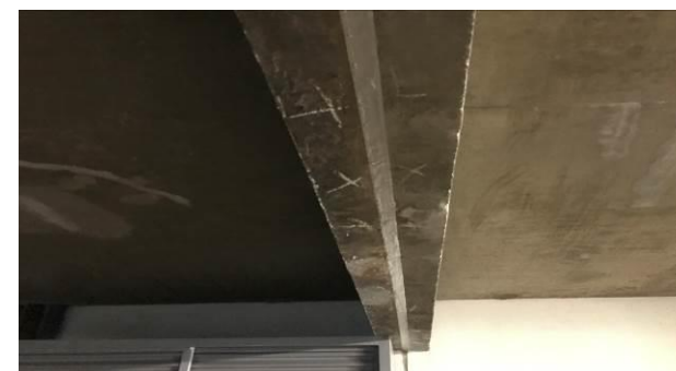
F22 – Tratamento parte inferior da junta (2º subsolo)
