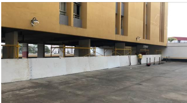
F3 – Tapume na área da Etapa 1 no 1º subsolo
