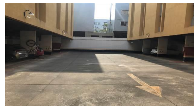
F6 – Saída de veículos antes das vagas interditadas da Etapa 1 no 1º subsolo
