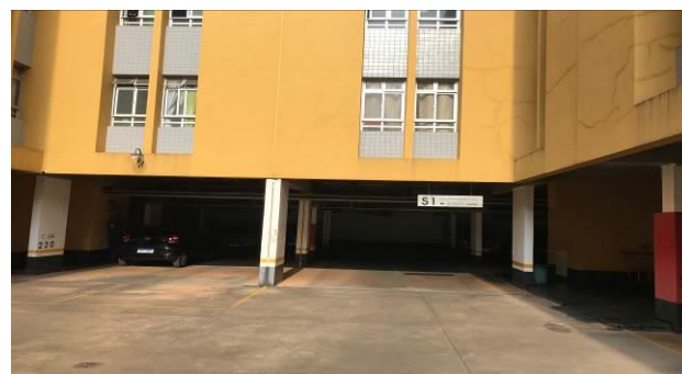
F5 – Saída de veículos antes das vagas interditadas da Etapa 1 no 1º subsolo
