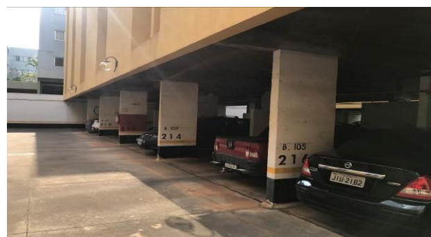
F7 – Área de circulação de veículos para saída da garagem (1º SS)
