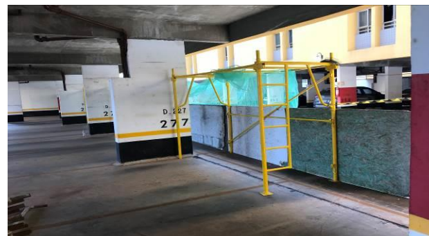
F4 –Vista interna da área de intervenção no 1º subsolo (Etapa 1)
