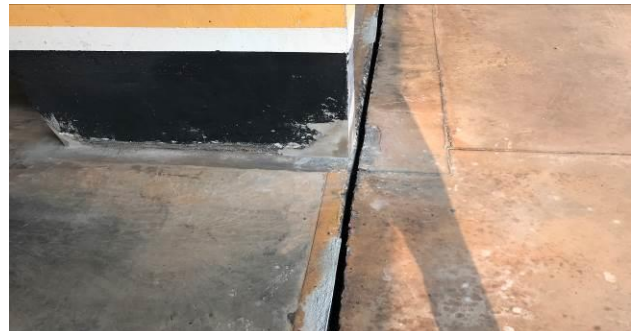
F2 – Limpeza e acerto bordas das juntas
