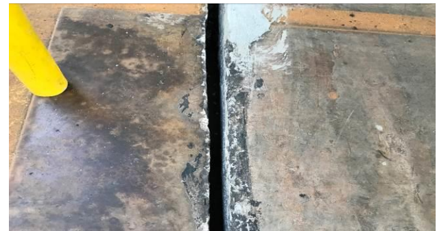
F4 – Limpeza e acerto bordas das juntas
