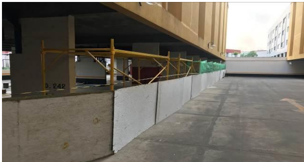
F1 – Vista do tapume
