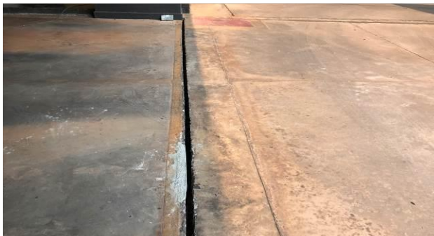
F3 – Limpeza e acerto bordas das juntas
