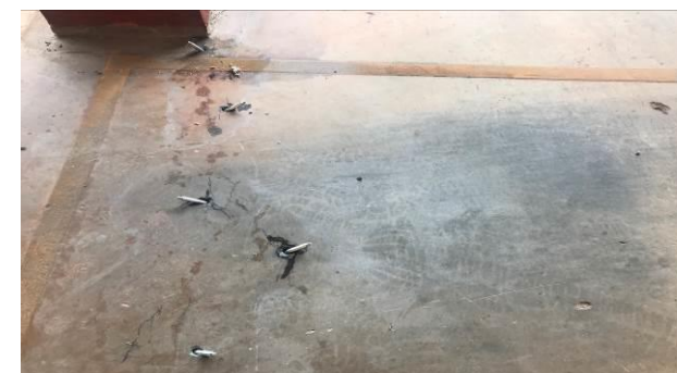
F14 – Obturação de fissuras no piso
