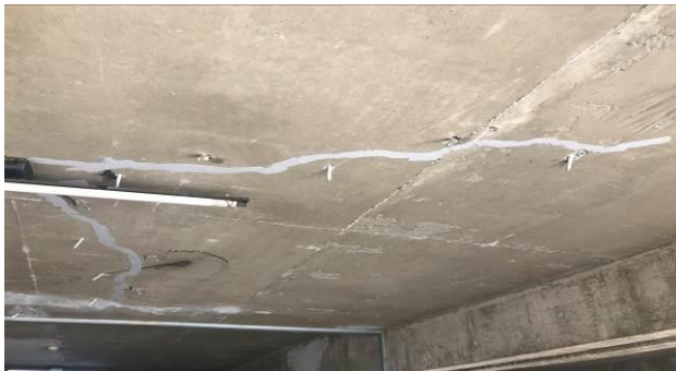
F5 – Aspecto final após injeção.
