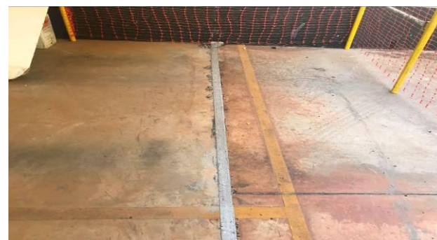
F13 – Junta do piso recuperada
