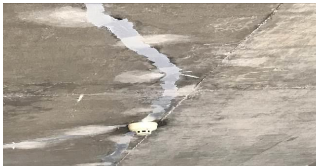
F9 – Vista após obturação da fissura
