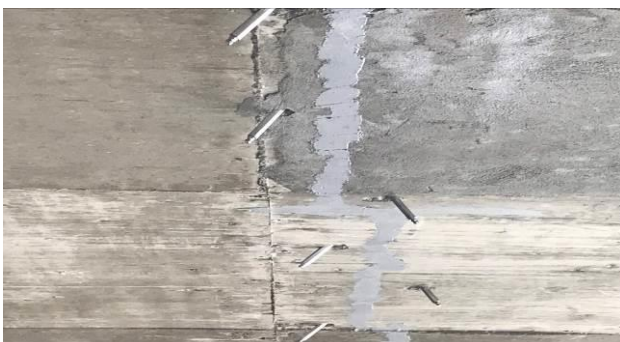
F8 – Vista da face inferior da laje. Fissura recuperada com injeção de epóxi
