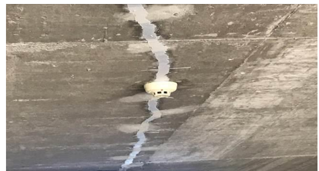
F8 – Vista após obturação da fissura
