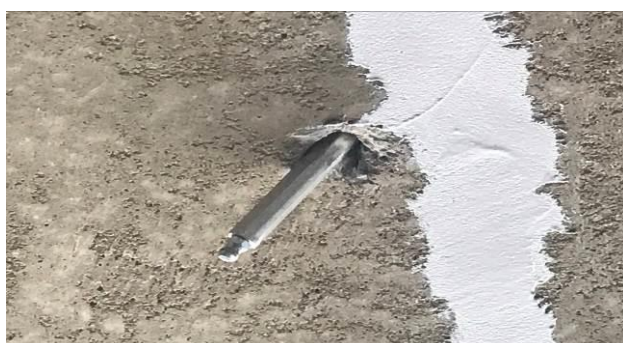
F11 – Detalhe bico de injeção
