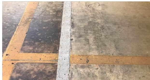
F18 – Junta de dilatação do piso após recuperação
