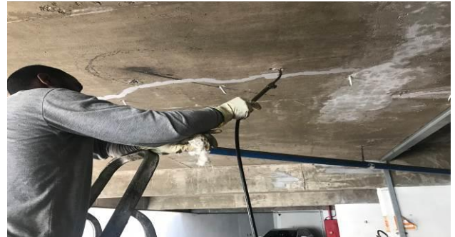
F2 – Aplicação de resina epóxi sob pressão
