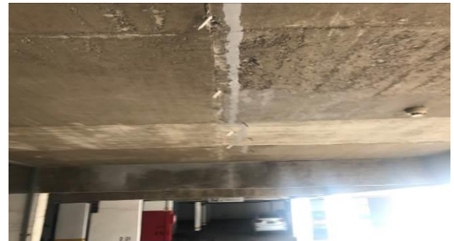
F6 – Área da laje de teto recuperada
