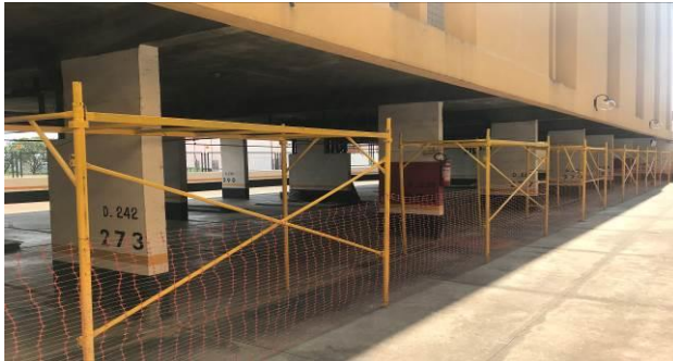
F1 – Vista da área protegida para aplicação da junta Jeene
