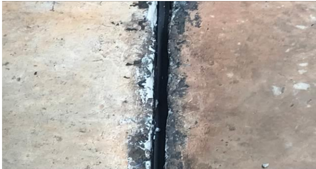
F9 – Junta de dilatação da PARTE 2 em recuperação
