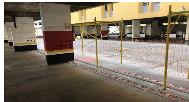
F12 – Vista geral da área entre a PARTE 1 e PARTE 2
