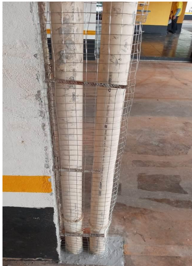
F17 – Recuperação do chumbamento na laje (foto cedida pela PIMAR)
