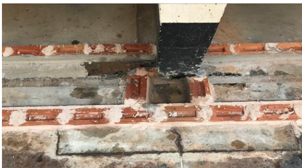
F5 – Alagamento para identificar vazamento pontual
