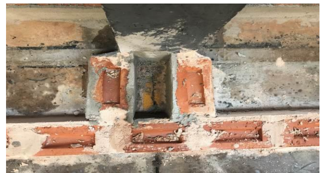
F6 – Alagamento para identificar vazamento pontual
