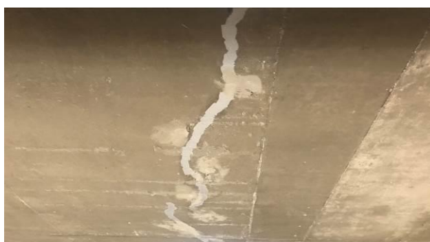
F3 – Finalização recuperação fissuras teto do 2º SS (ETAPA 1)
