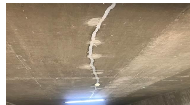
F6 – Finalização recuperação fissuras teto do 2º SS (ETAPA 1)
