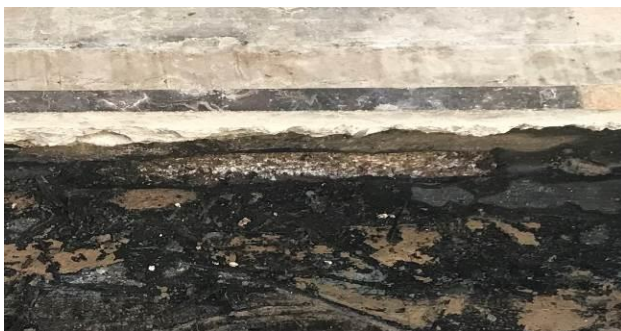
F13 – Remoção do enchimento e da manta asfáltica
