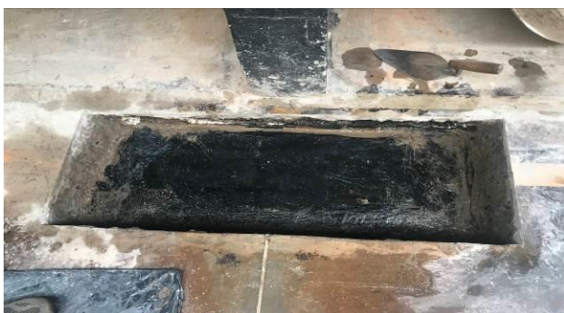
F11 – Camada de impermeabilização com manta asfáltica
