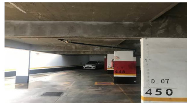
F8 – Vista do teto do 2º SS onde foram recuperadas as fissuras (ETAPA 1)
