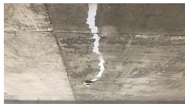
F4 – Finalização recuperação fissuras teto do 2º SS (ETAPA 1)
