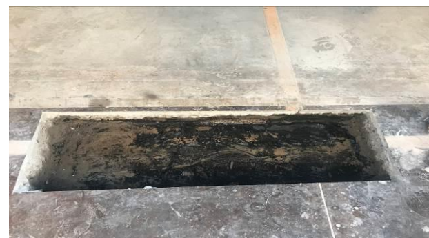
F12 – Camada de impermeabilização com manta asfáltica (ao lado da junta)
