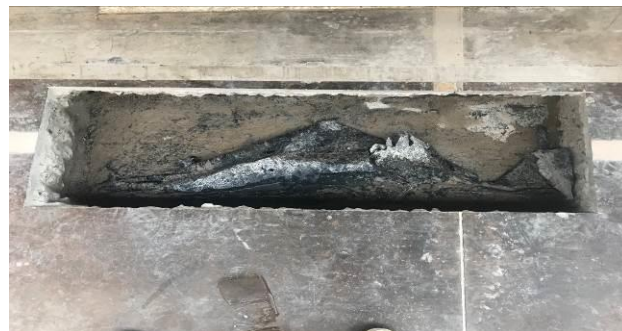
F10 – Camada de separação plástica sobre o enchimento da laje
