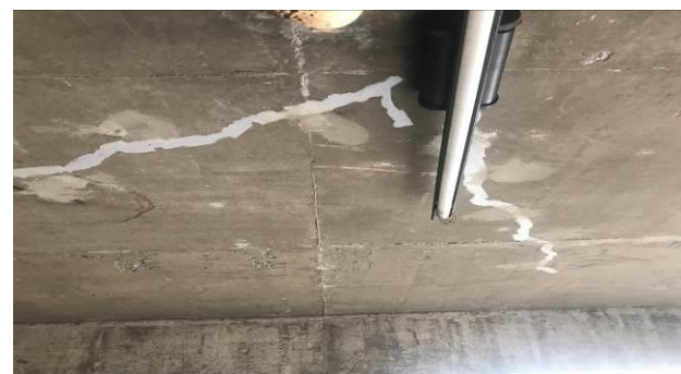
F5 – Finalização recuperação fissuras teto do 2º SS (ETAPA 1)
