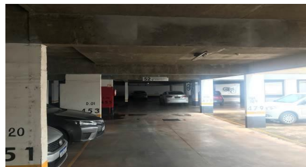
F7 – Vista do teto do 2º SS onde foram recuperadas as fissuras (ETAPA 1)
