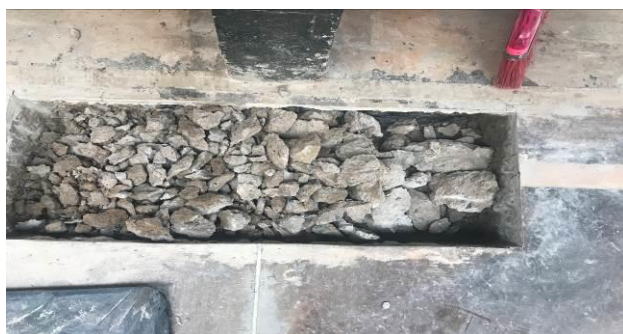
F9 – Abertura na junta da ETAPA 1 para identificar a origem do vazamento ocorrido
