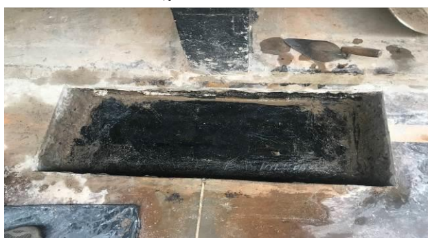
F11 – Camada de impermeabilização com manta asfáltica
