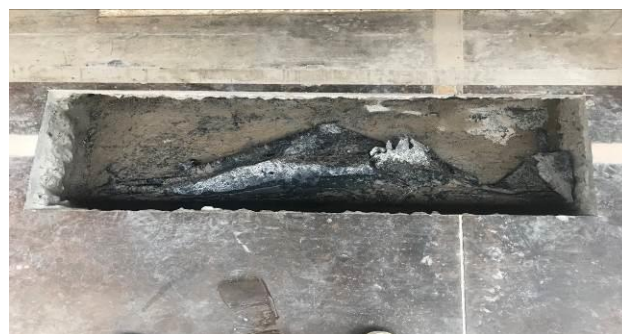
F10 – Camada de separação plástica sobre o enchimento da laje
