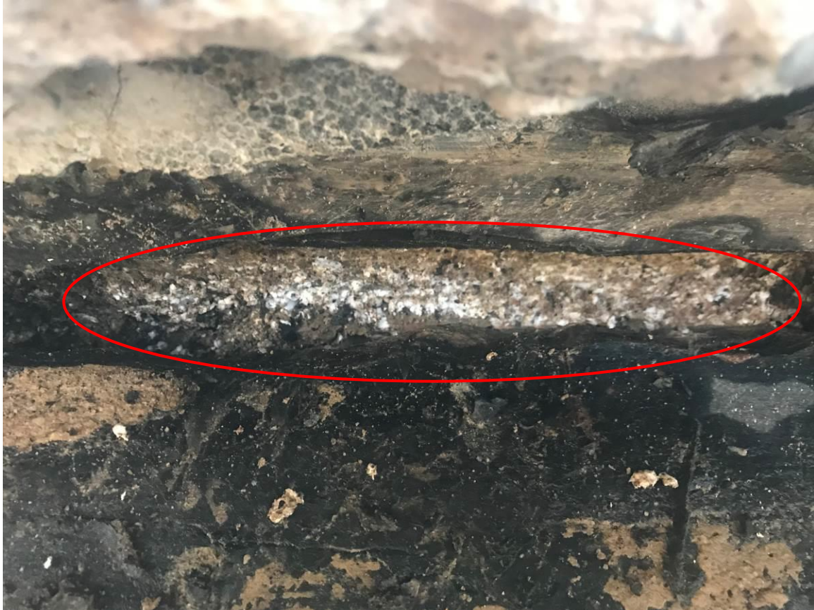
F16 – Foto da abertura de 35 cm x 60 cm executada no enchimento sobre a laje de circulação de veículos, de modo a detectar a origem das infiltrações nas juntas de dilatação, que ocorreram após a recuperação das juntas. Nota-se a placa de isopor logo após a manta asfáltica, comprovando a inexistência de impermeabilização da junta estrutural da laje de teto do 2º subsolo.
